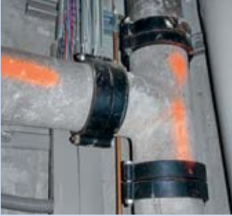
Asbestzement-Rohre
