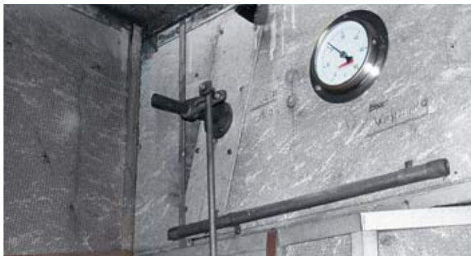
Lüftungskanal aus Asbestzementplatten
