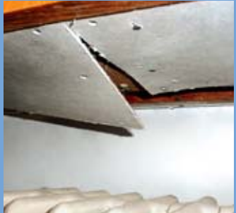
Asbesthaltige Leichtbauplatten
