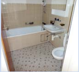
Asbesthaltiger Kleber hinter den Platten
