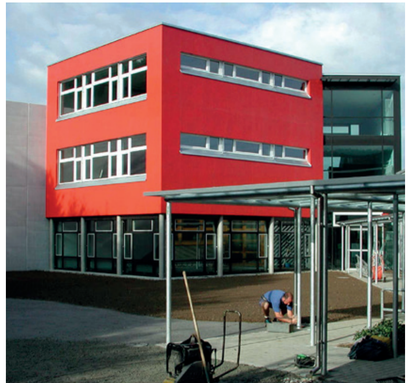
Erweiterung des Ausbildungszentrums in Dagmersellen 2001/2002
