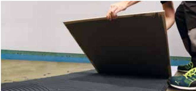
Codex Power RX 11 Outdoor ist ca. 60 Minuten verarbeitbar und nach 6 Stunden verfug- und begehrbar.
