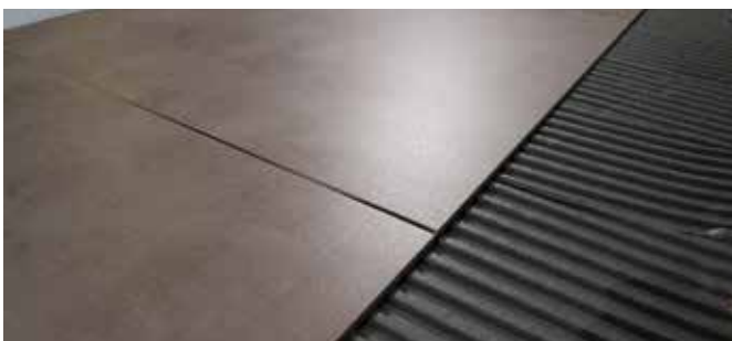
Platten bis 120 Zentimeter Kantenlänge problemlos im Aussenbereich verlegt.
