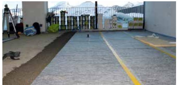
Tragfähiger Boden mit dem UZIN Turbolight-System – das Verbundsystem lässt sich mit dem Pumpservice schnell auf die Fläche bringen und ist auch in unterschiedlichen Schichtstärken sehr stabil.
