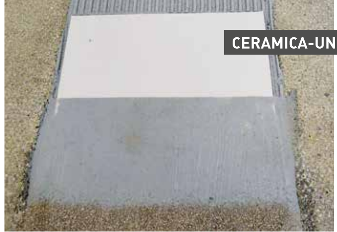
Baumaterial wird auf die Einwirkungen von Kälte und Hitze getestet. Il materiale da costruzione viene collaudato per gli effetti di caldo e freddo.
