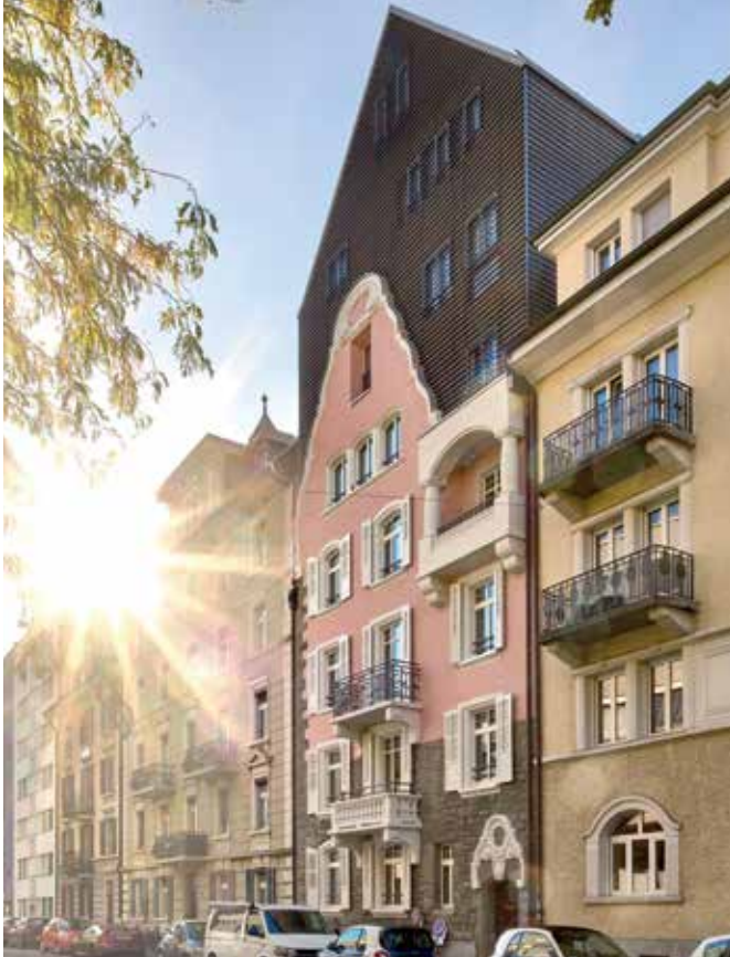
Je nach Gebäude kommen auch traditionelle Platten zum Einsatz (Erweiterung Stadthaus Lindenstrasse in Luzern).
