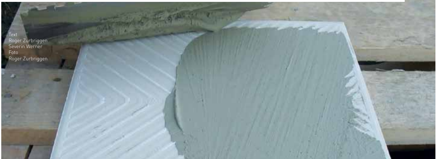
Abb. 1: Kratzspachtelung auf der Rückseite einer Feinsteinzeugplatte (aus Bühler et al. 2014).
