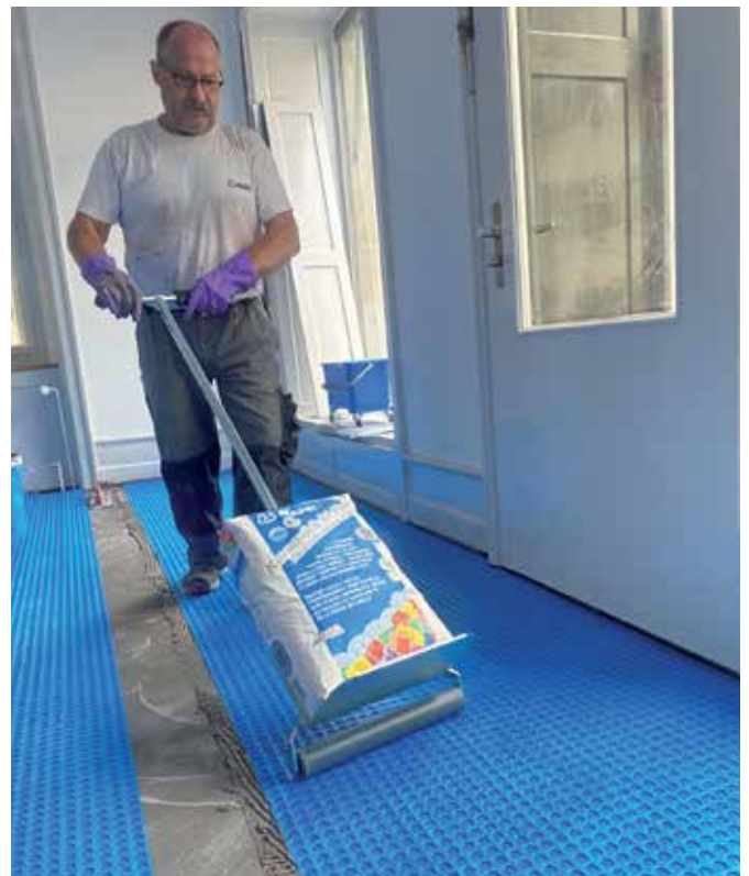
Fachgerechte Verarbeitung von Mapeguard UM 35.
