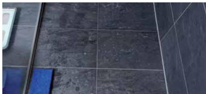
Reinigungsversuche bei einem Duschboden, Feinsteinzeug mit Schieferoberfläche.
