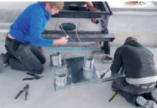
... Metallarbeiten für ein Cheminée.
