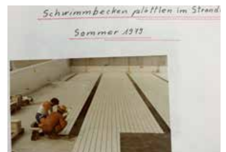
Aus dem Firmenalbum: Arbeiten am ersten Freiluft-Pool in Sarnen anno 1979.
