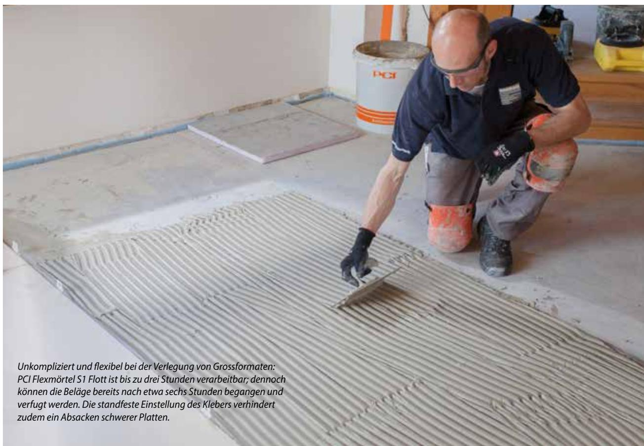
*Unkompliziert und flexibel bei der Verlegung von Grossformaten: PCI Flexmörtel S1 Flott ist bis zu drei Stunden verarbeitbar; dennoch können die Beläge bereits nach etwa sechs Stunden begangen und verfugt werden. Die standfeste Einstellung des Klebers verhindert zudem ein Absacken schwerer Platten.*
