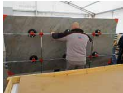
Ein Traggerüst der Firma Montolit (SPV Gönner) wird vorgeführt.
