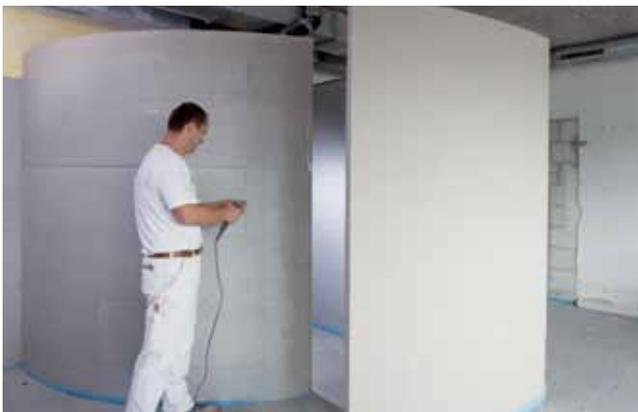
*Die Platten werden trocken direkt über der Unterkonstruktion aus CW-Ständerprofilen und UW-Anschlussprofilen gebogen und wie gewohnt befestigt.*
