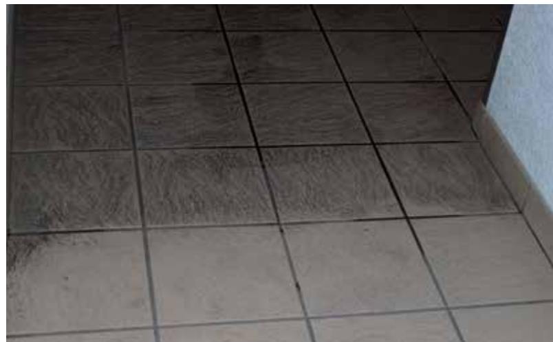
Industrieboden vor (hinten) und nach sachgemässer Reinigung. Sol industriel avant (à l'arrière) et après un nettoyage adapté.
