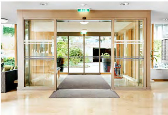
Abbildung 25 Stufenloser und bodenebener Zugang
