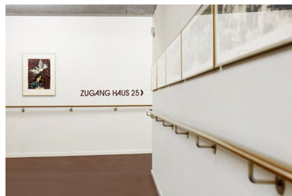
Abbildung 48 Beidseitiger Handlauf im Korridor
