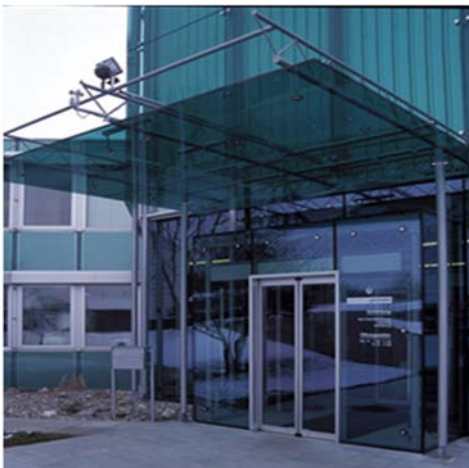
Abbildung 30 Hauseingang mit Wetterschutz
