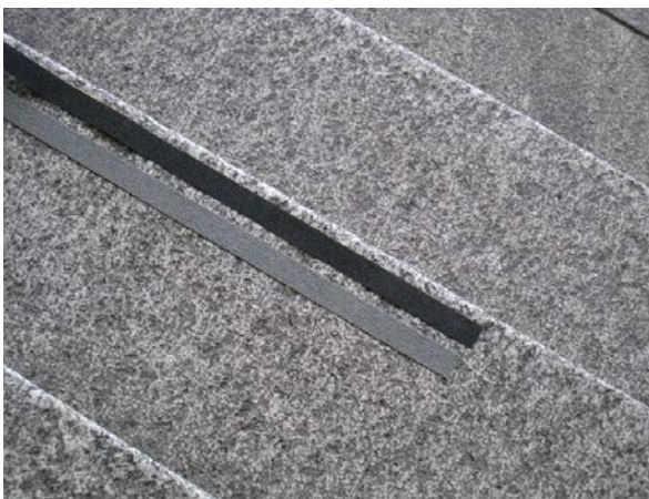
Abbildung 27 Antirutsch-Bänder machen auf Treppenkanten aufmerksam
