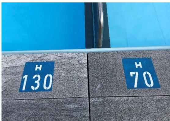
Abbildung 7: Kennzeichnung der Wassertiefen am Beckenrand
